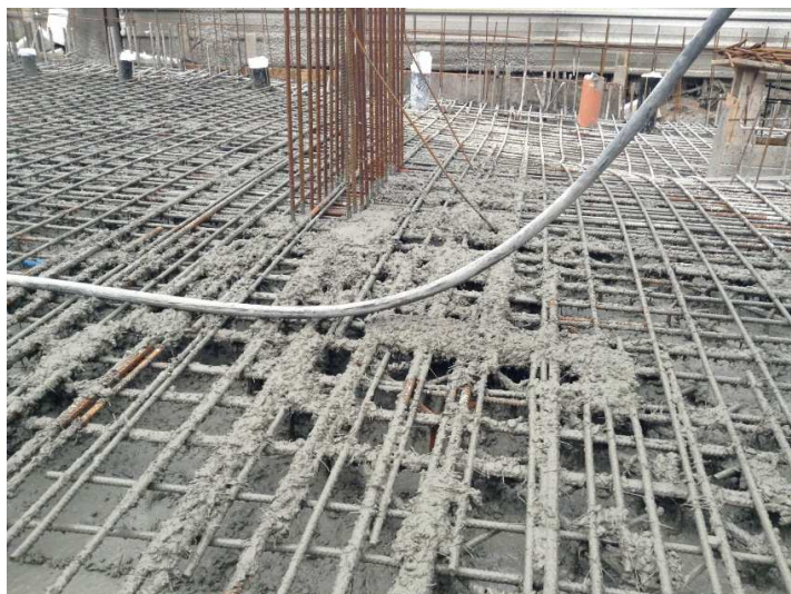
Рисунок 1. – Бетонирование двухслойного монолитного перекрытия
