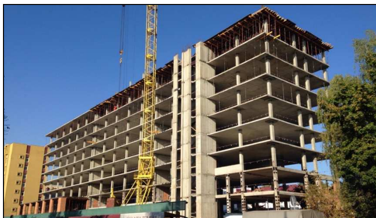
Рисунок 9. – Объект на стадии реконструкции (сентябрь 2015 года)
