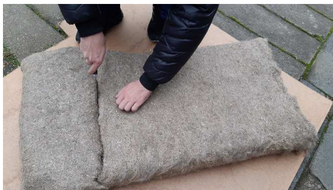
Рисунок 1. – Резка ножом плиты из льняных очёсов
