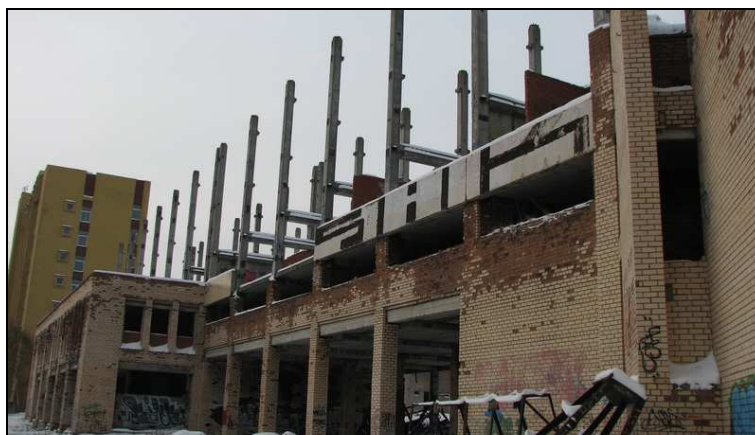
Рисунок 4. – Общий вид обследуемого объекта по оси «А»
