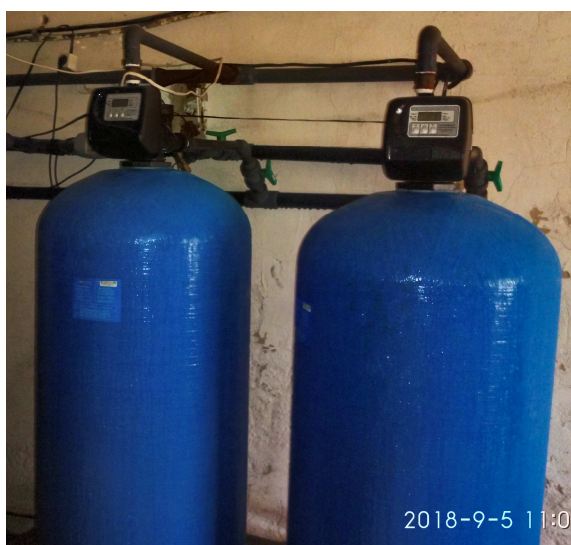
Рисунок 1. – Общий вид установки водоподготовки
