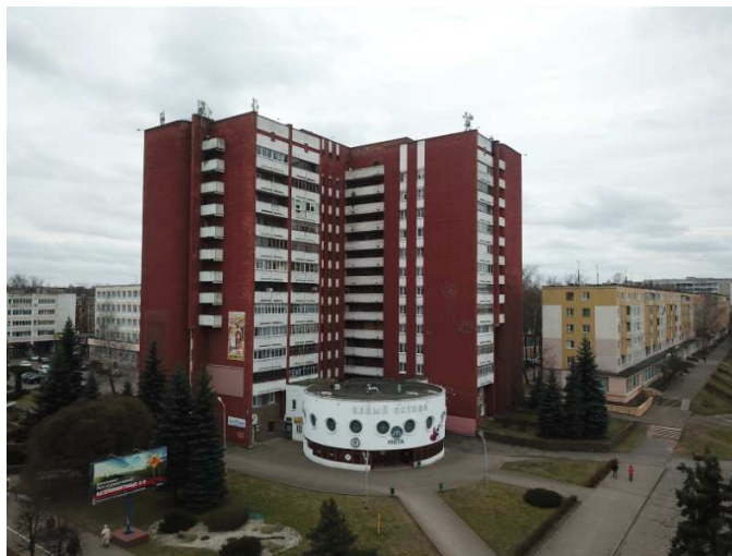
Рисунок 1. – Пристройка «Белый остров» в городе Новополоцке
