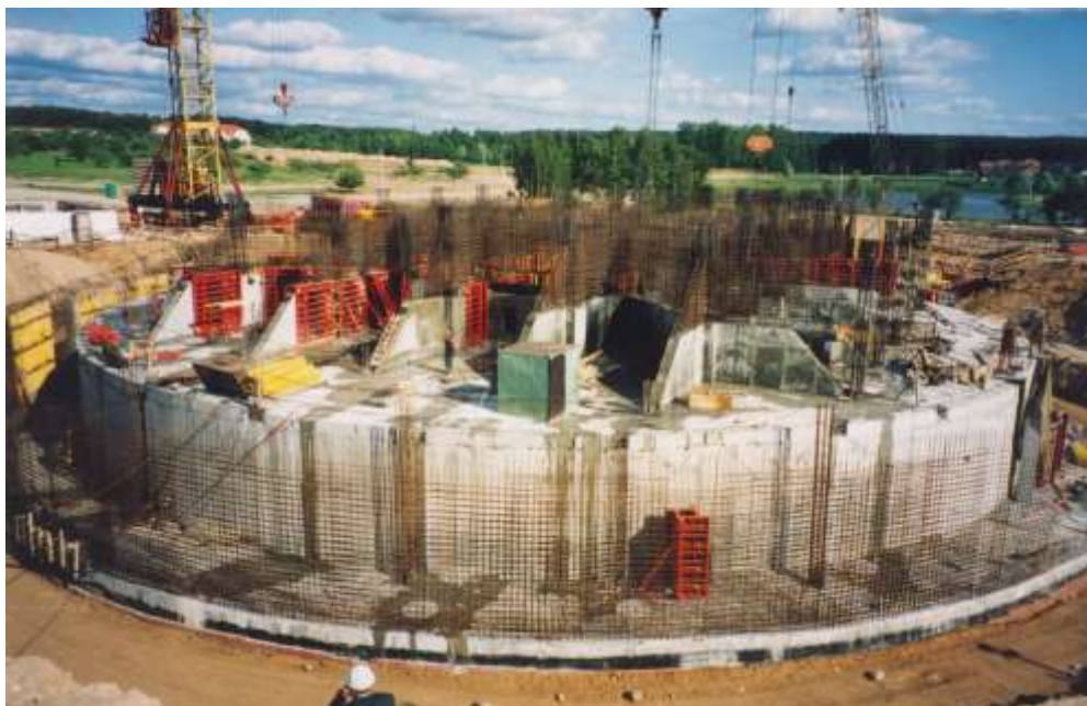
Рис. 1. Внешний вид монолитного фундамента в процессе строительства
