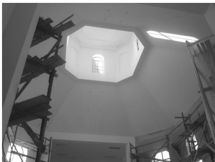
Рис. 5. Общий вид бетонного купола костела после снятия опалубки
