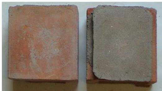
Рис. 4. Разрушение образца на цементно-известковом растворе
