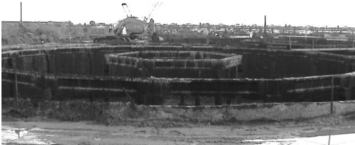
Рис. 1. Общий вид резервуара емкостью 10000 м 3
