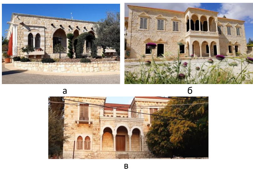
а – г. Каф Тибнит (реконструкция арх. М. Бошар); б – г. Адайси (реконструкция арх. М. Бошар); в – г. Каф Руман. Снимки автора
