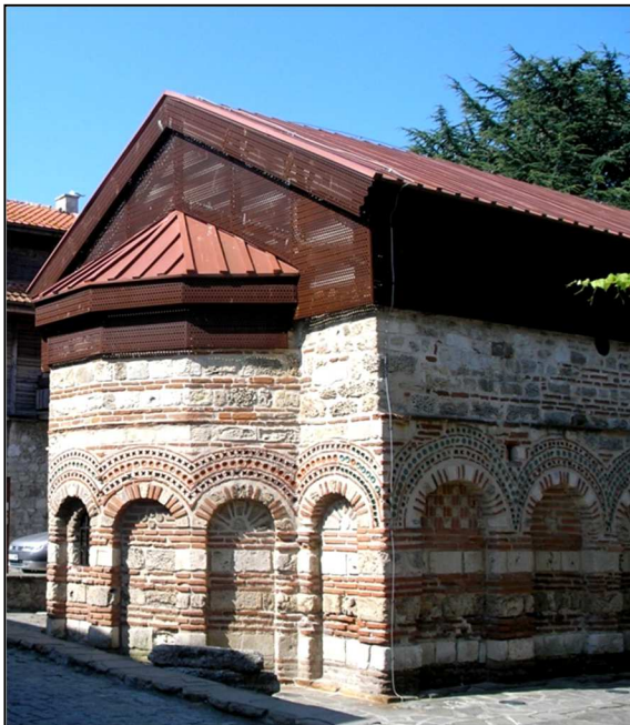
Рисунок 43. – Древняя кладка из плитнякового керамического кирпича, Болгария
