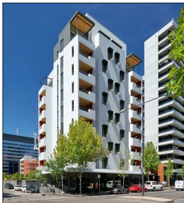
Рисунок 4. – Дом из клееных деревянных панелей
