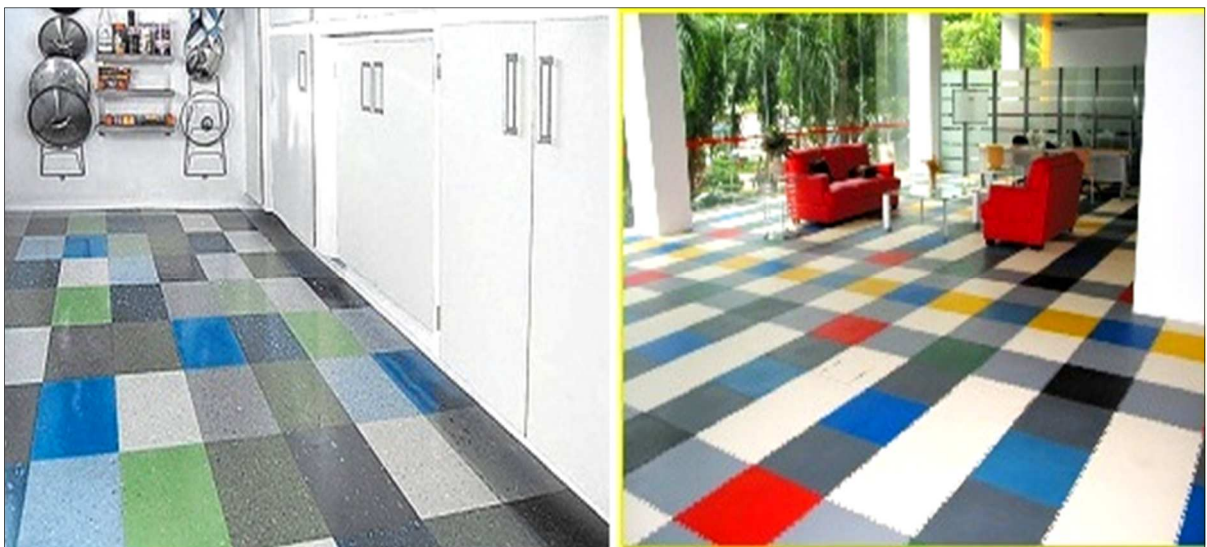
Рисунок 22. – Применение половой плитки ПВХ
