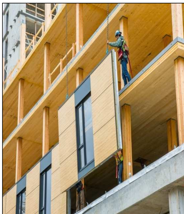
Рисунок 3. – Монтаж деревянных панелей
