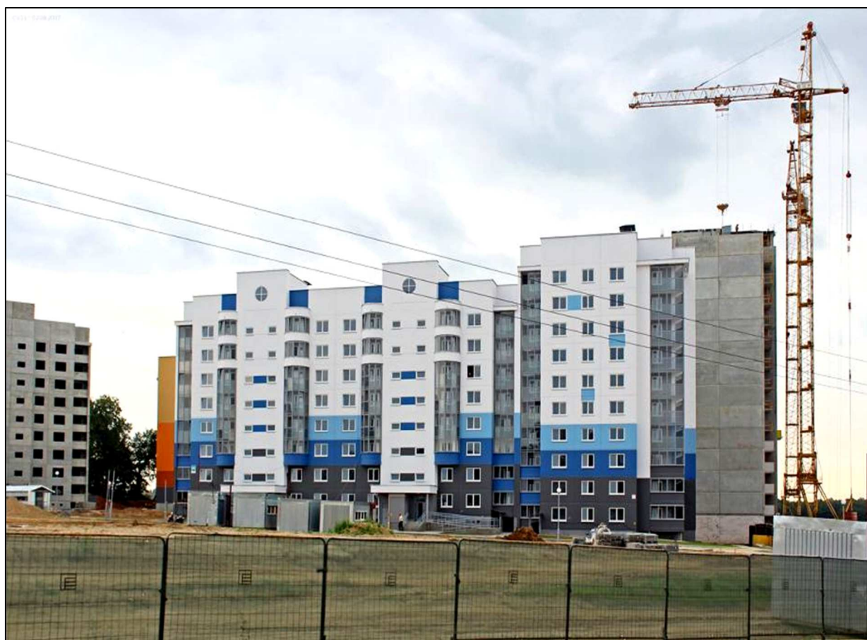
Рисунок 80. – Сборное строительство крупнопанельного дома
