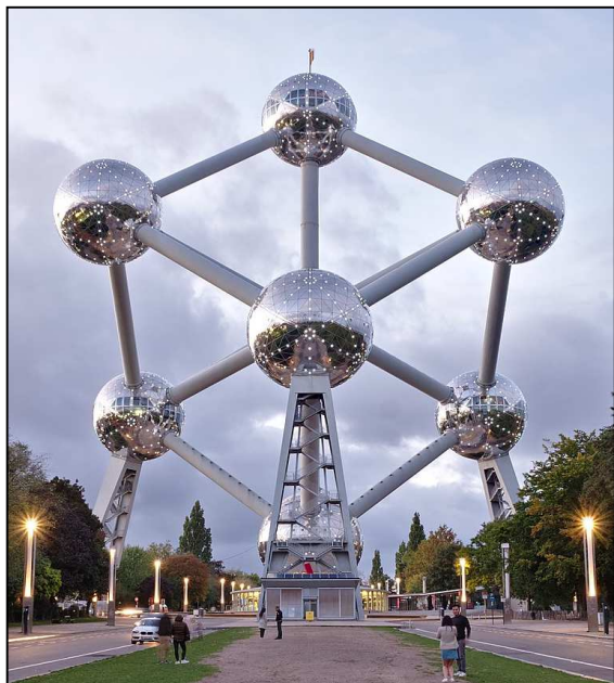
Рисунок 66. – Атомиум – стальная конструкция эксплуатируемых 9 сфер диаметром 18 м, соединенных эскалаторами и коридорам
