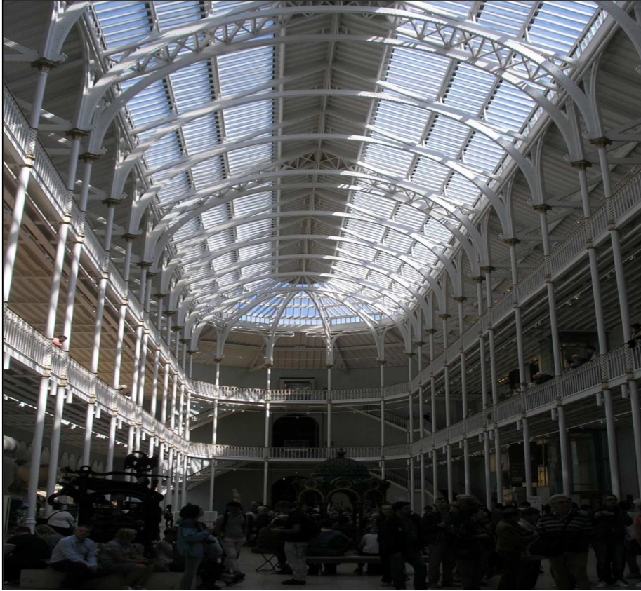
Рисунок 92. – Арочная конструкция стеклометаллического потолка, Национальный музей. Эдинбург, Шотландия
