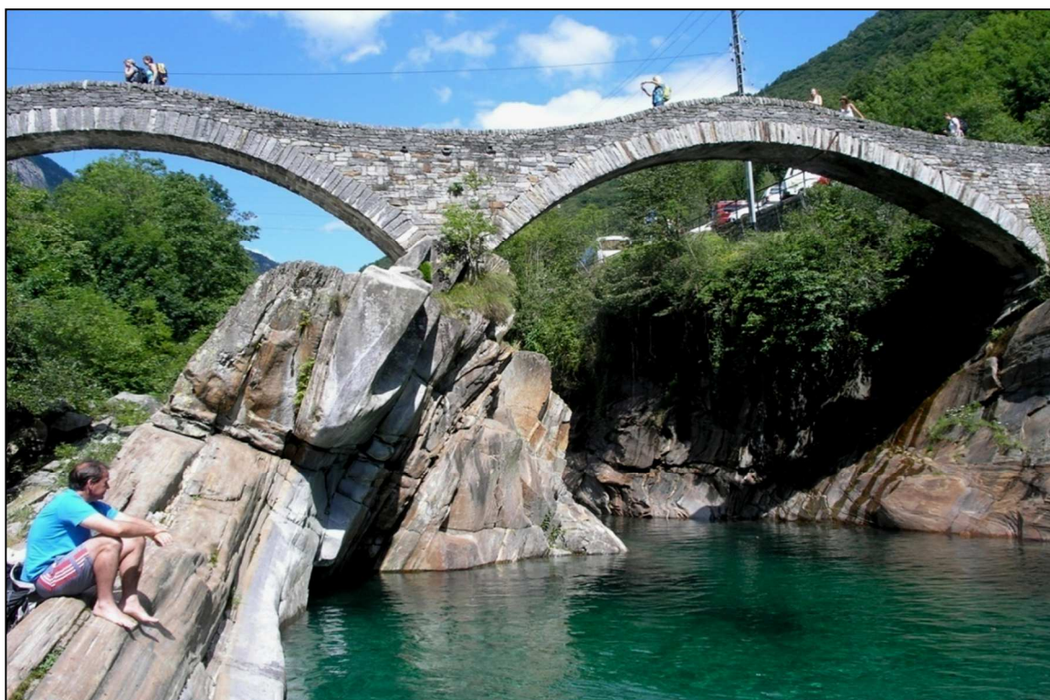
Рисунок 34. – Каменный мост, Швейцария
