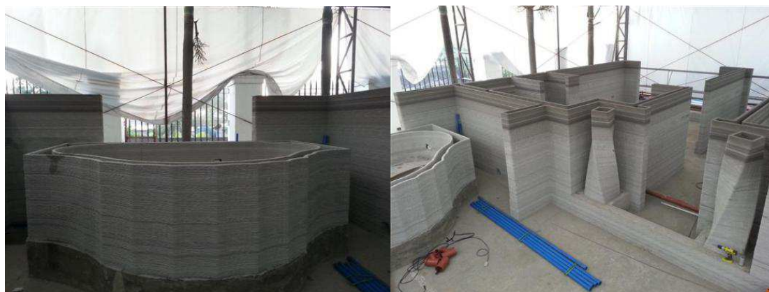
Рисунок 3. –Процесс строительства номера отеля Lewis Grand
