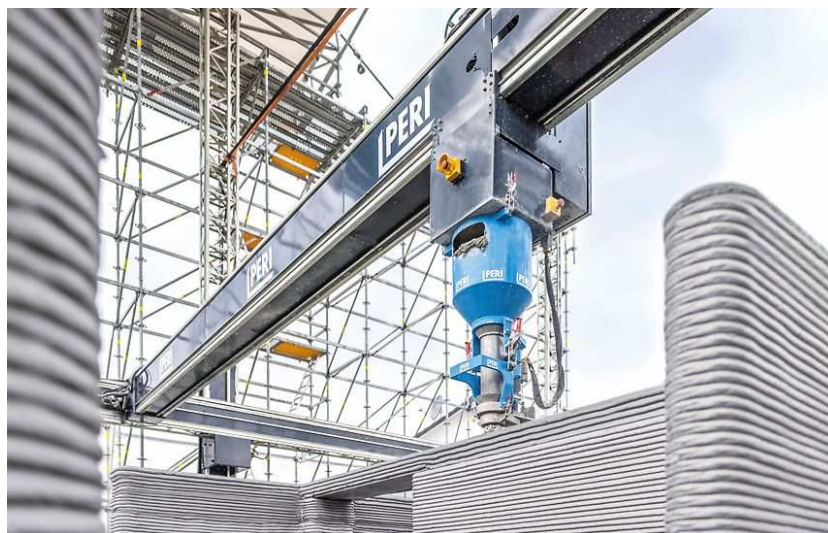
Рисунок 1. –Принтер, используемый компанией Perí
