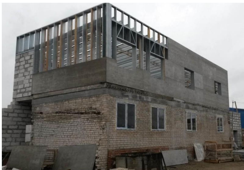
Рисунок 1. – Общий вид здания с каркасом второго этажа и обшивкой наружной стороны листами ЦСП
