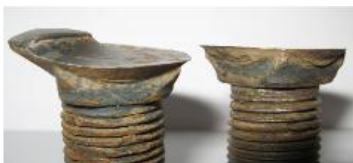
Рис. 2. Износ головок болтов с наплавленным покрытием
