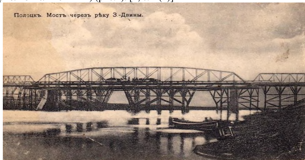
Рис. 2. Железнодорожный мост через р. Западная Двина. С открытки начала XX века. Издание писчебумажного магазина М.М. Лившица в г. Полоцке НПИКМЗ
