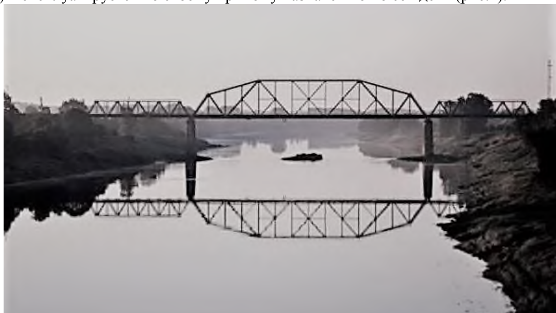
Рис. 4. Современный вид железнодорожного моста через Западную Двину в Полоцке. Фото
