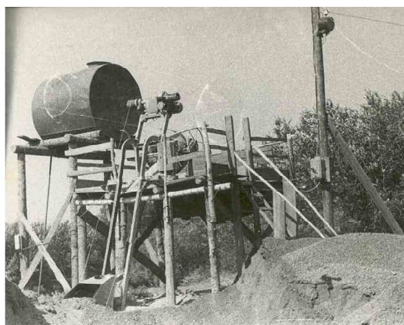
заработал растворобетонный узел,
