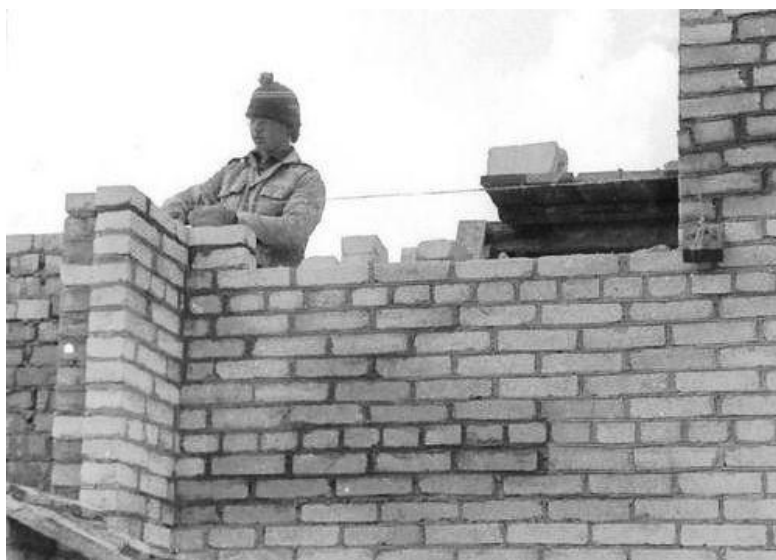
ССО «Эврика-2» на строительстве жилых домиков в д. Вороницы
