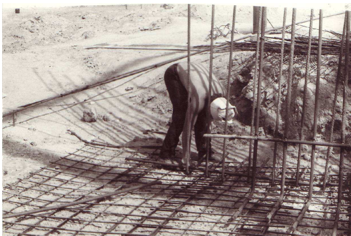
Владимир Стахейко в ССО «Политехник», г. Лепель, строительство склада минеральных удобрений
