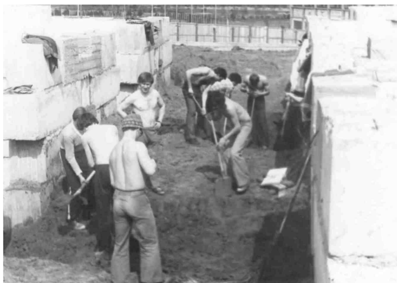
ССО «Эврика-2» на закладке фундамента общежития № 2 НПИ
