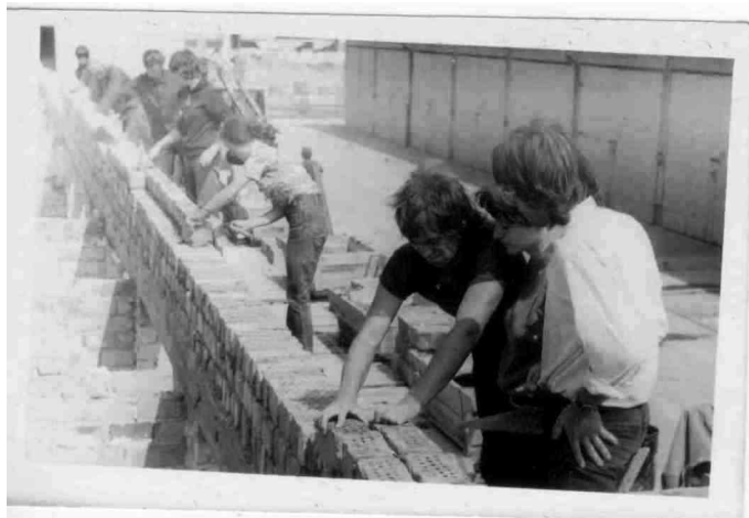
За работой на очистных сооружениях шинного комбината в г. Фюстервальде
