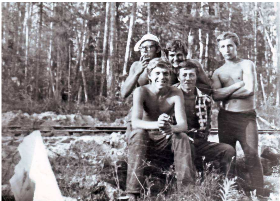
Воспитательный момент. Слева направо: Студенты-стройотрядовцы А. Игнатьев, С. Звонарев (в рубашке), С. Сизов (в кепке), Б. Голованов осуществляют воспитательную работу с подростком, включенным в состав отряда
