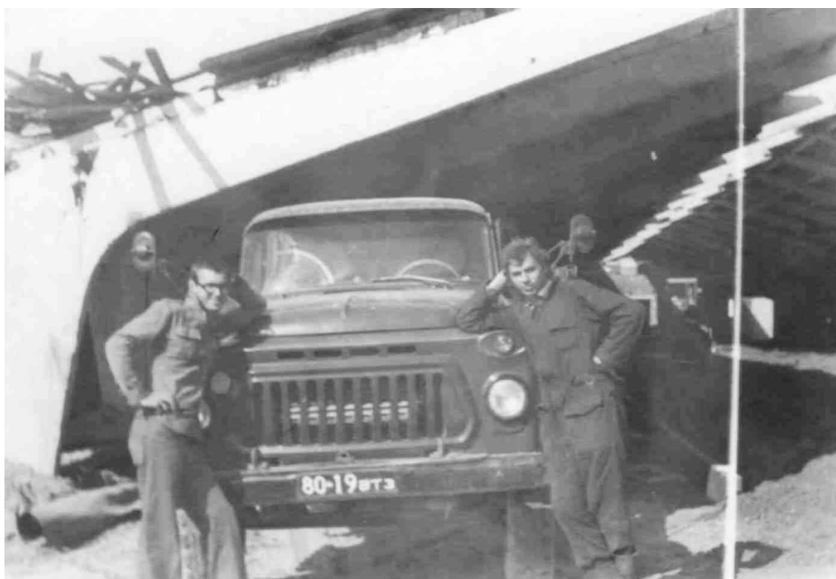
Игорь Троицкий (слева) и Александр Зеленков во время работы на строительстве овцефермы в д. Черневичи Глубокского р-на
