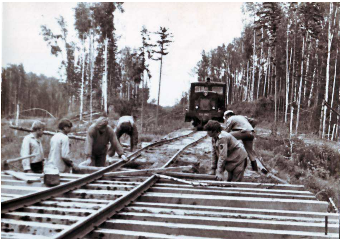
Так производится выравнивание проложенного нового участка узкоколейки перед тем, как будет производиться формирование насыпи
