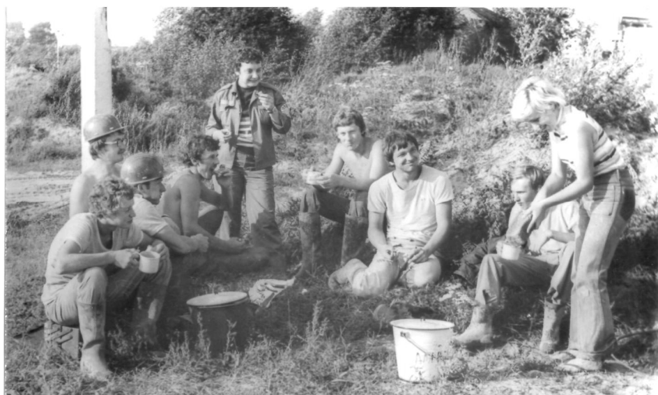
ССО «Ритм». Дополнительное питание прямо на объекте
