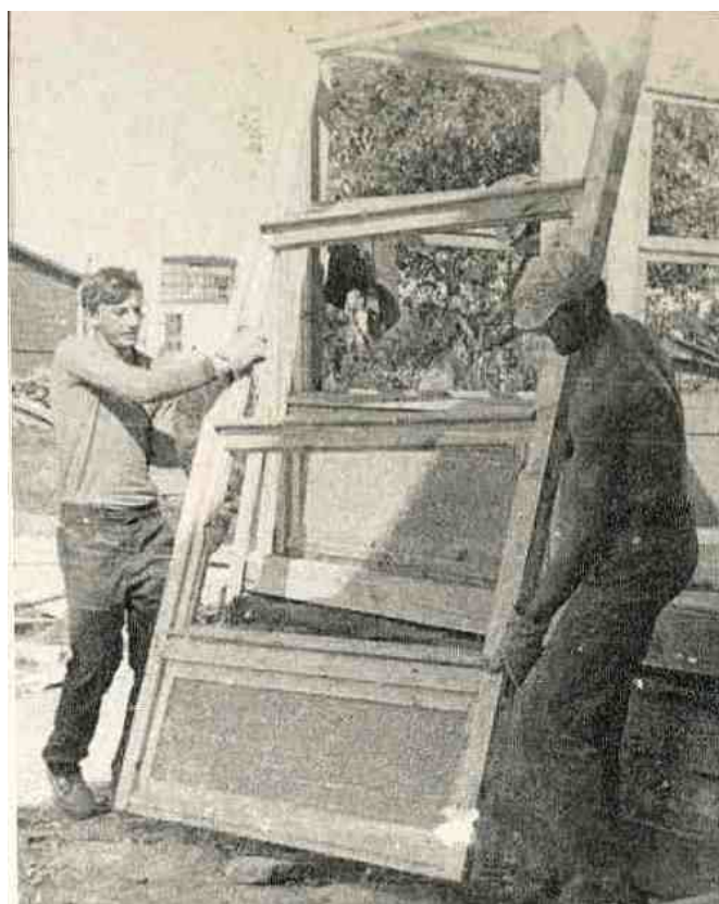
Бойцы «Эврики-71» на строительстве веранды детского сада в г.п. Глубокое
