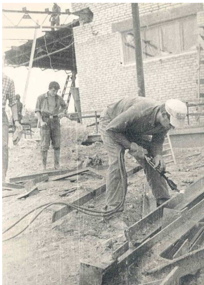
Строительство ramпы Глубокского молочно-консервного комбината. На переднем плане человек огненной профессии – газорезчик Валерий Голосуев
