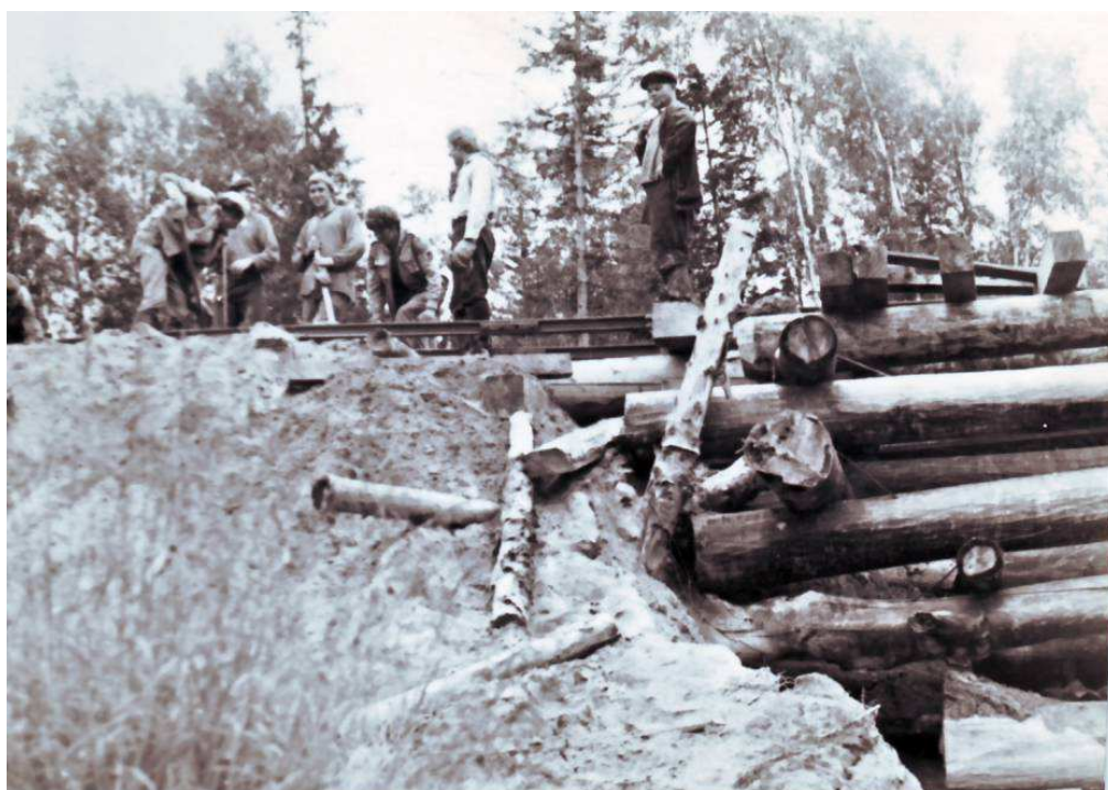
Преодоление железнодорожным полотном ям и мелких оврагов (затем вся конструкция засыпается землей и формируется насыпь)
