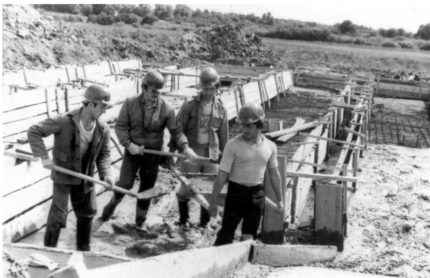
ССО «Ритм». Строительство очистных сооружений
