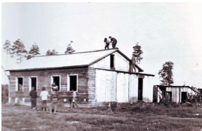
Строительство жилья в леспромхозовском поселке. Скоро новоселье
