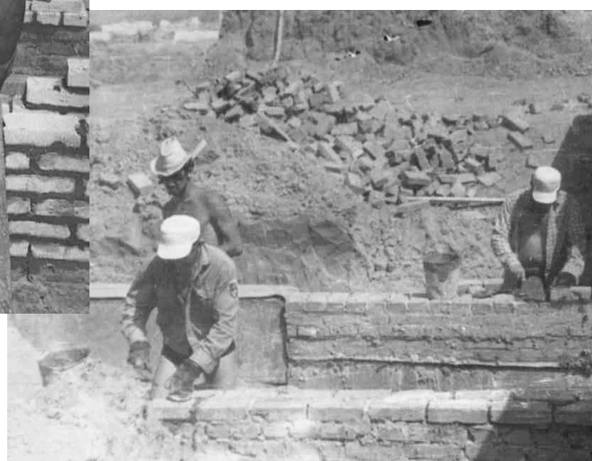
каменщики начали закладывать фундамент,
