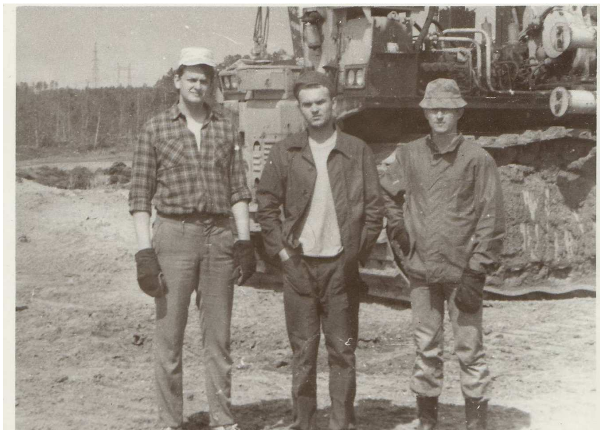
Тюменская область г. Нижневартовск, Бойцы стройотряда Пивоваров Владимир (86 ТВ), Сеньшов Виктор и Селезнев Анатолий (88 ТВ-2). Строим газопровод и школу
