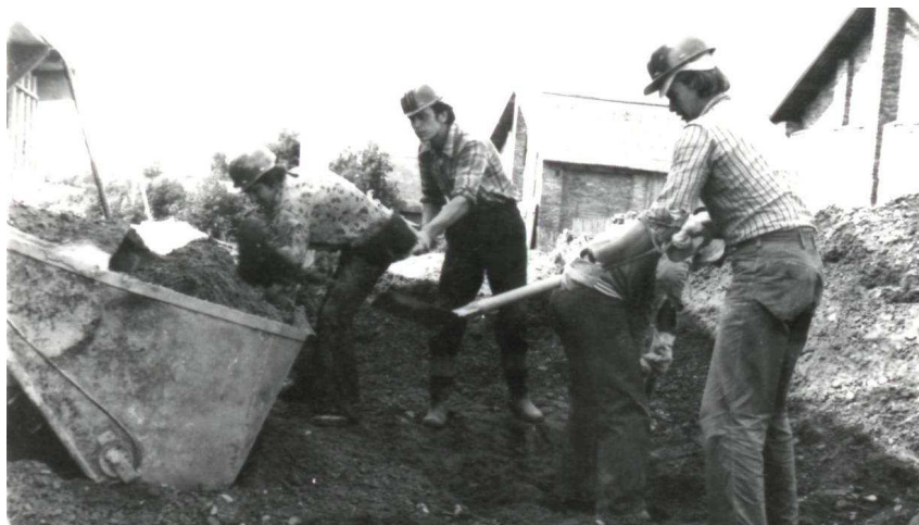
ССО «Ритм». Подготовка бетона
