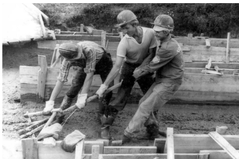
ССО «Ритм». Строительство очистных сооружений. Всё вручную!
