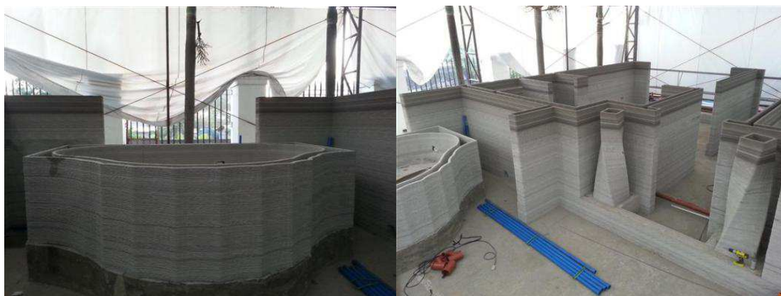
Рисунок 3. –Процесс строительства номера отеля Lewis Grand
