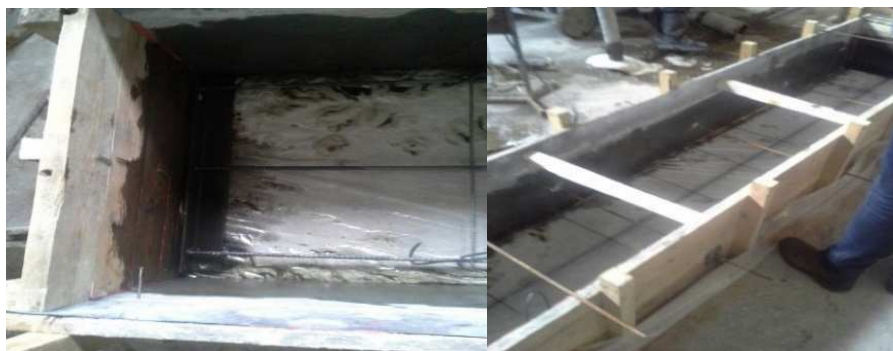
Рисунок 3. – Арматурная сетка, уложенная в опалубку
