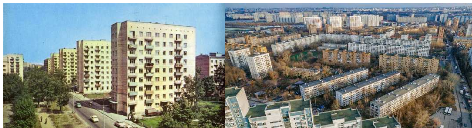
Рисунок 3. – Типовая 9-ти и 5-ти этажная застройка в СССР
