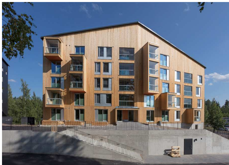
Рисунок 3. – Здание жилого комплекса «ruukuokka»
