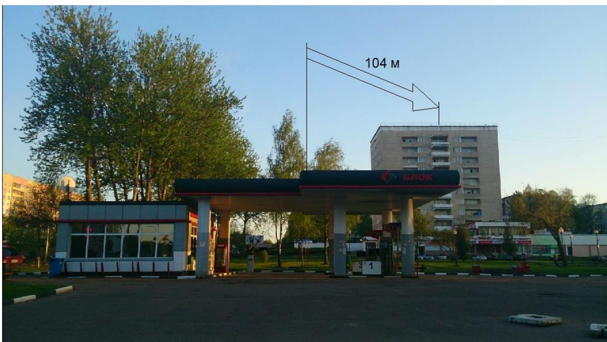
Рис. 4.3. АЗС «Блок» возле моста через р.Зап.Двина. Расстояние до жилого дома - 104м.
