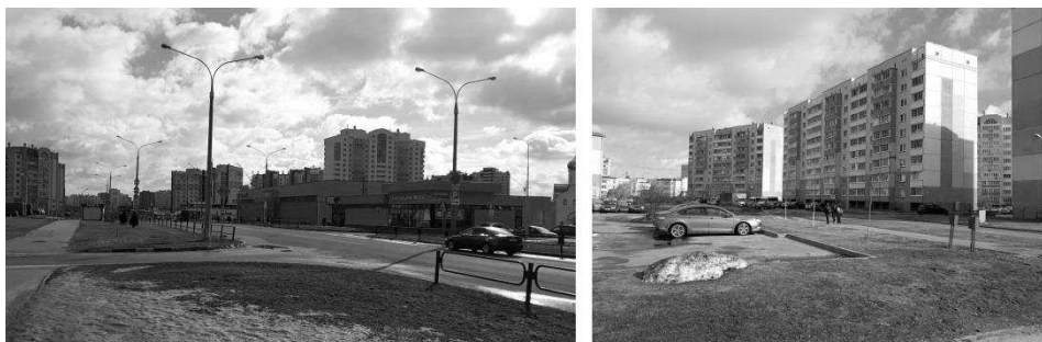
Рисунок 2. – Жилые и общественные здания микрорайона Билево-1
