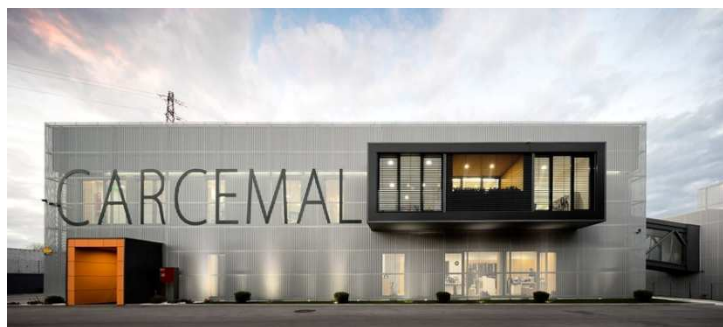
Рисунок 2. – Текстильная фабрика «CARCEMAL» в г. Барселона, Португалия. Вид после реконструкции
