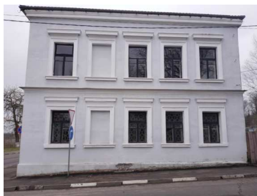
Рисунок 4. – Центральный фасад здания
