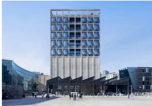
Рисунок 5. – Отделка фасада здания бывшего зернового бункера окнами-панелями в г. Кейптаун, ЮАР (арх. Т. Хетервик)
