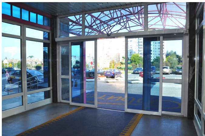
Рис. 3. Автоматические раздвижные двери
