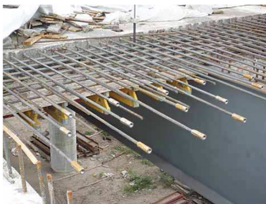
Рис. 2. Общий вид стыкования арматурных стержней
