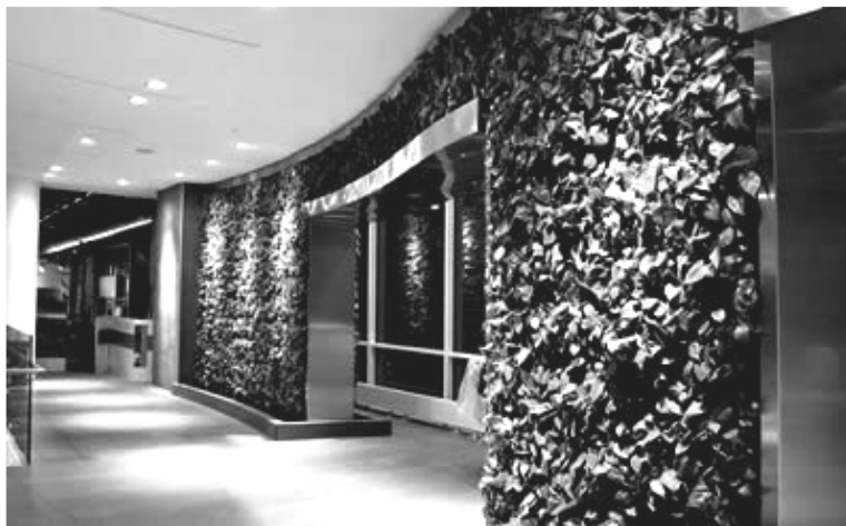
Рис. 1. Вертикальное озеленение внутренних стен зданий
