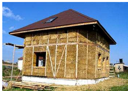
Рис. 1. Монтаж дома из соломенных блоков
