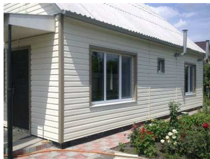
Рис. 4. Здание с облицовкой из металлического сайдинга
