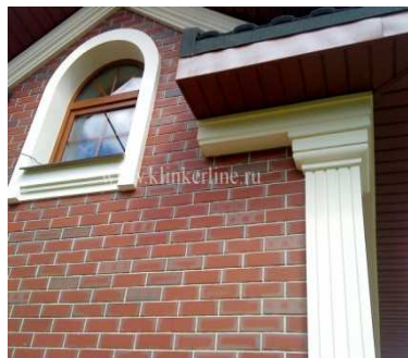
Рис. 3. Отделка фасада клинкерной плиткой
