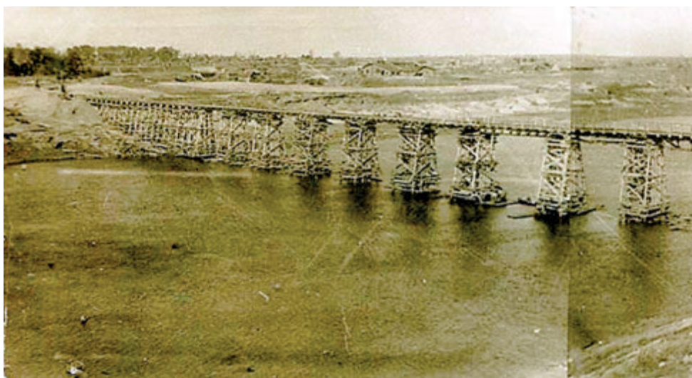
Фото 3. Восстановленный транспортно-пешеходный мост через р. Зап. Двина 1944 г.
