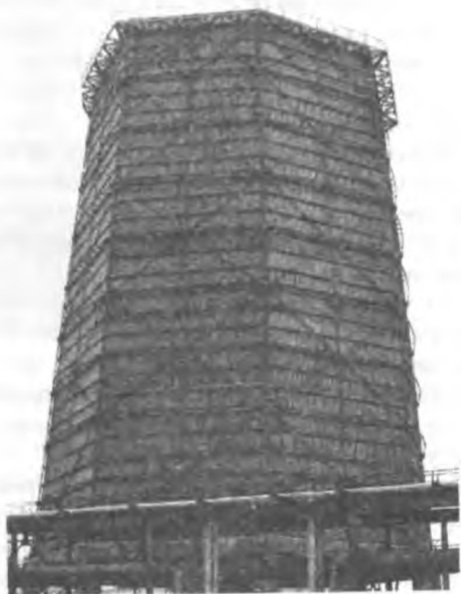
Рис. 1. Вытяжная башня градирни № 1
