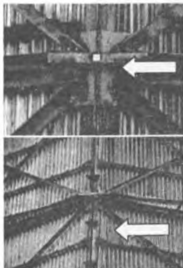
Рис. 3. Отражающая пленка с перекрестием для визирования на вытяжной башне градирни № 1
