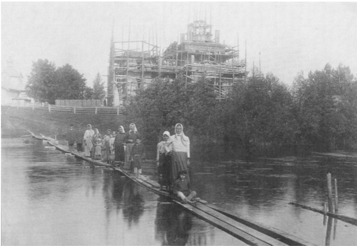
Строительство церкви в с. Чернецово
