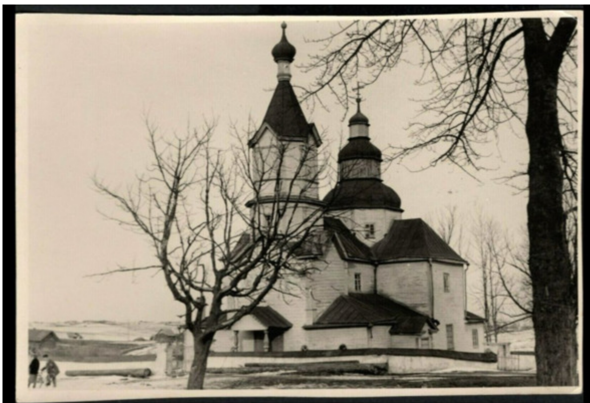
Плисская церковь 5-го января 1942 года
