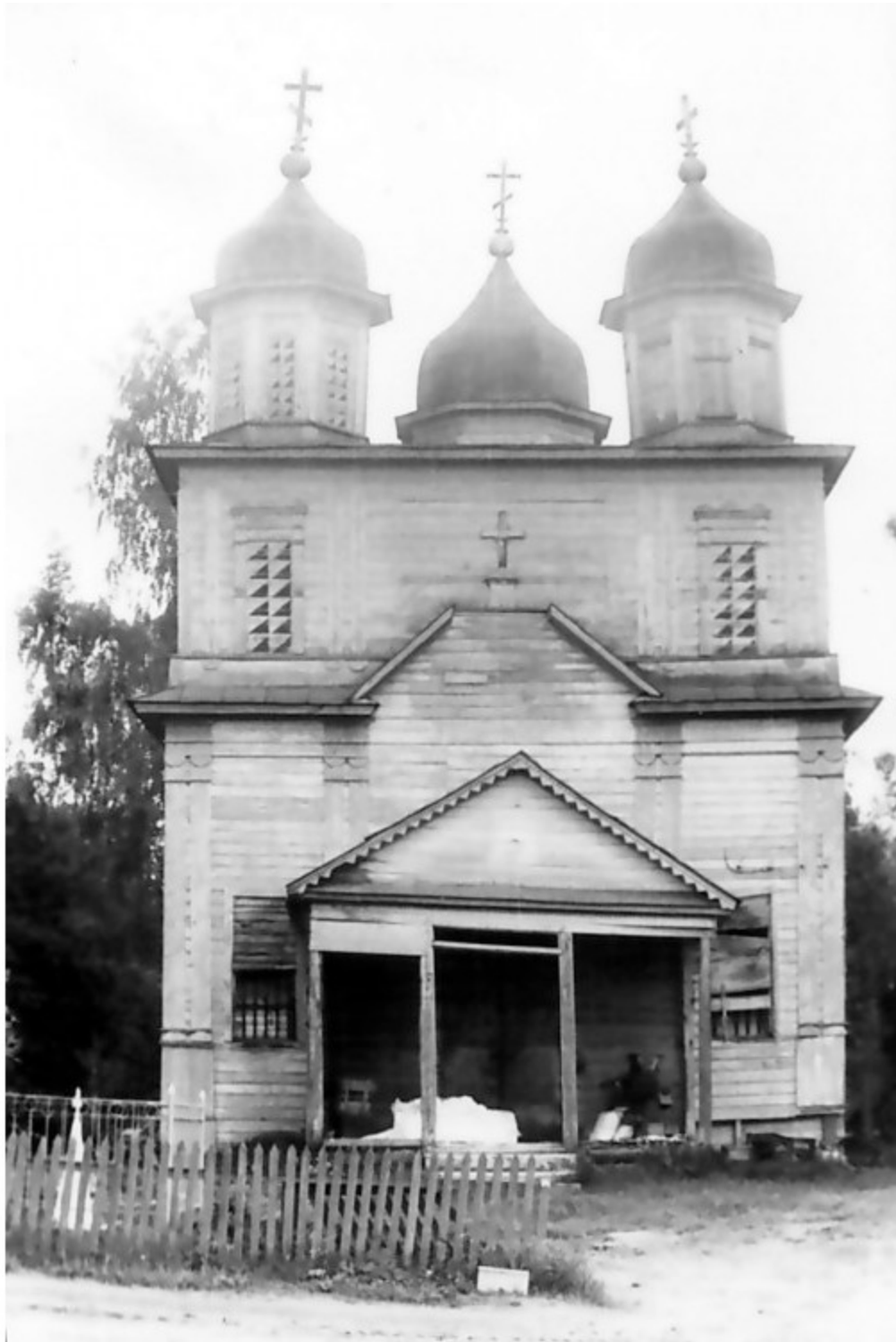
Покровская церковь с. Стайки, фото 1978 года
