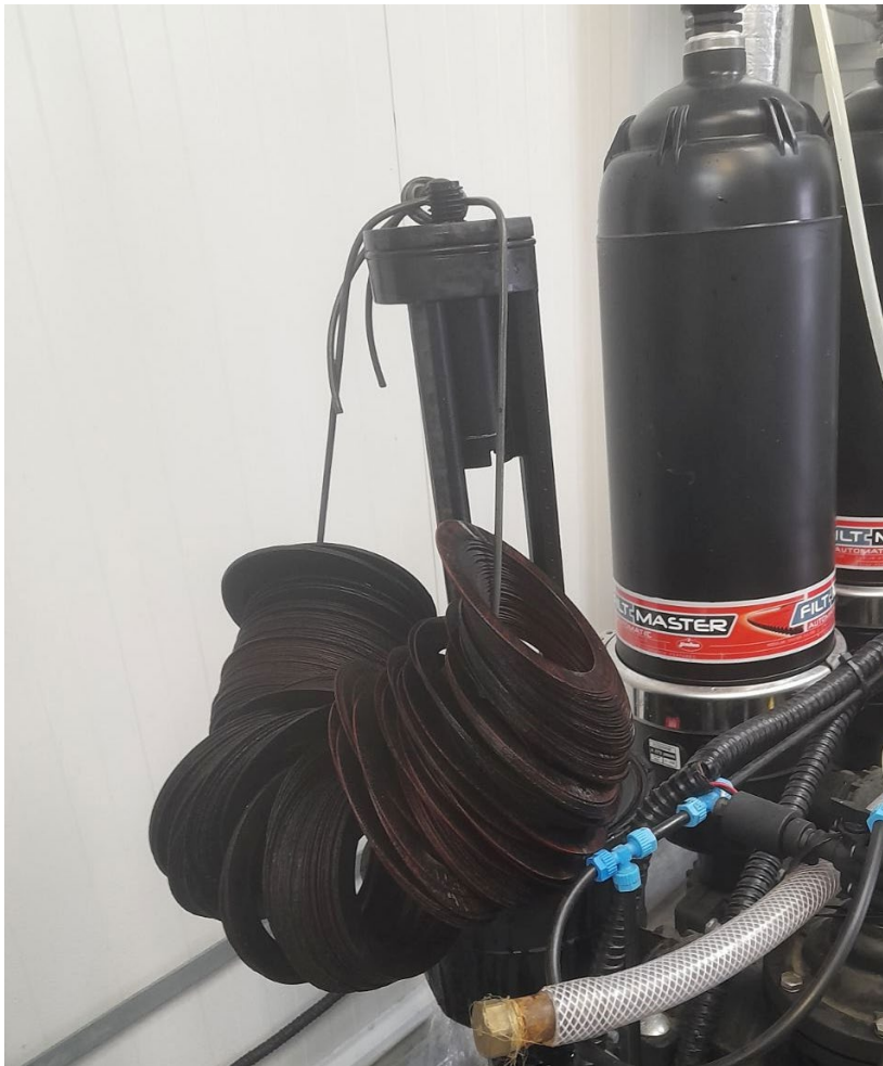
рисунок 3.2. Загрязненные диски, извлеченные из картриджа.
