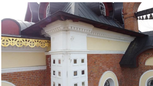
Рисунок 3. – Фото архитектурных элементов крупным планом
