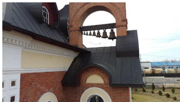
Рисунок 4. – Фото архитектурных элементов и конструкций крупным планом
