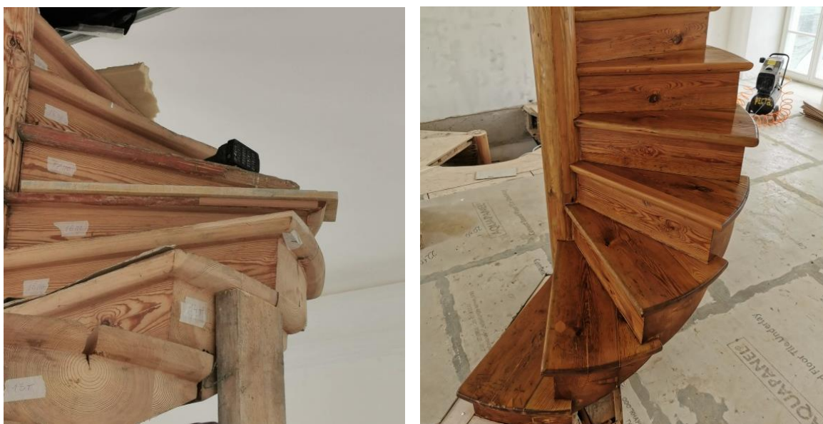
Рисунок 6. – Реставрация винтовой деревянной лестницы дворца Булгаков (ОАО «Белреставрация»)
