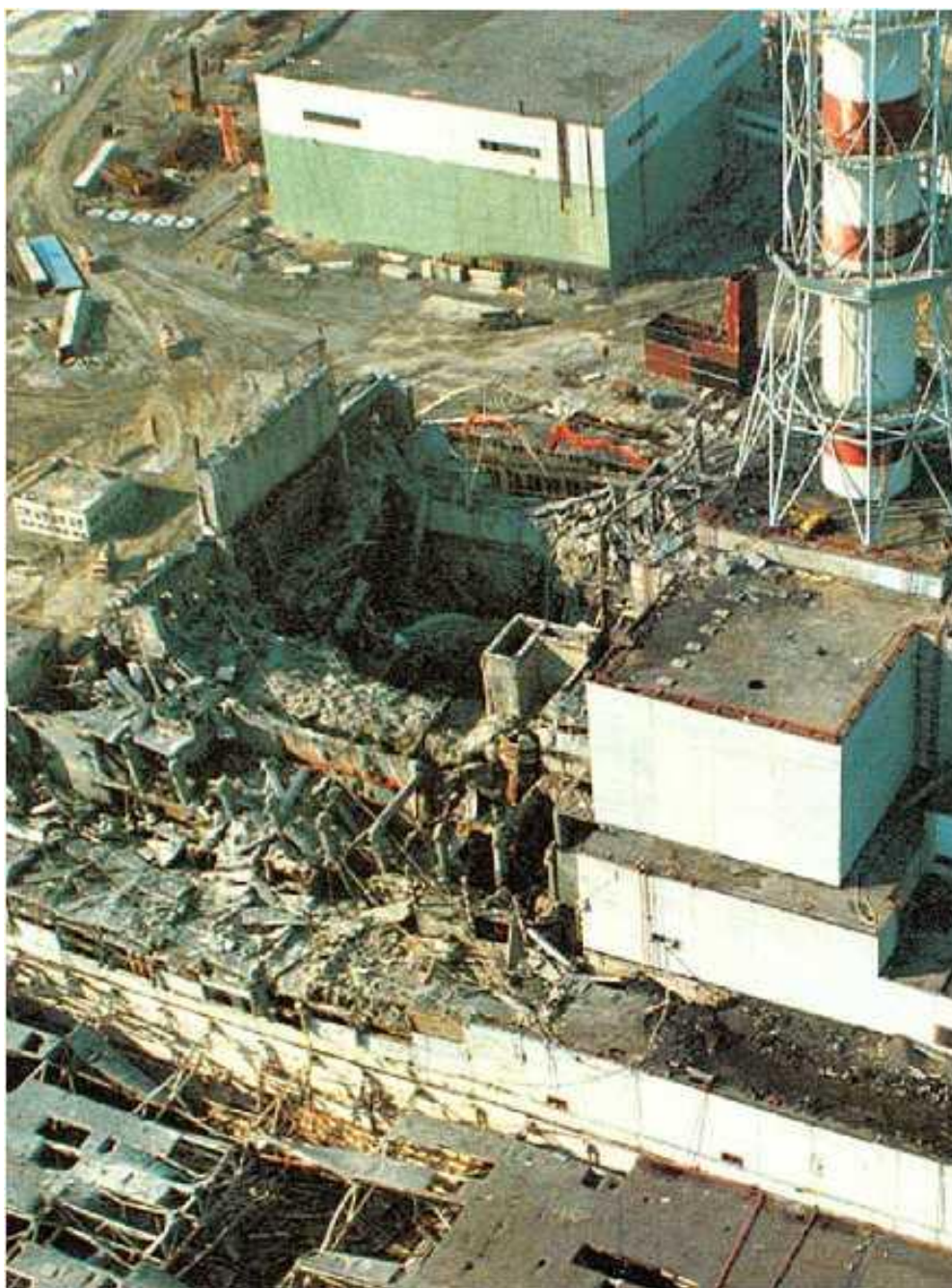
Рисунок 15.2.2. – Разрушенный четвертый энергоблок
