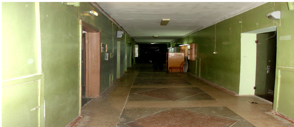
Фото N 1. Общий вид помещения на момент осмотра со стороны входной двери
