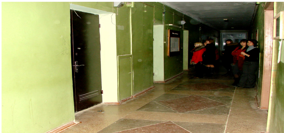
Фото N 3. Общий вид части помещения на момент осмотра со стороны окна
