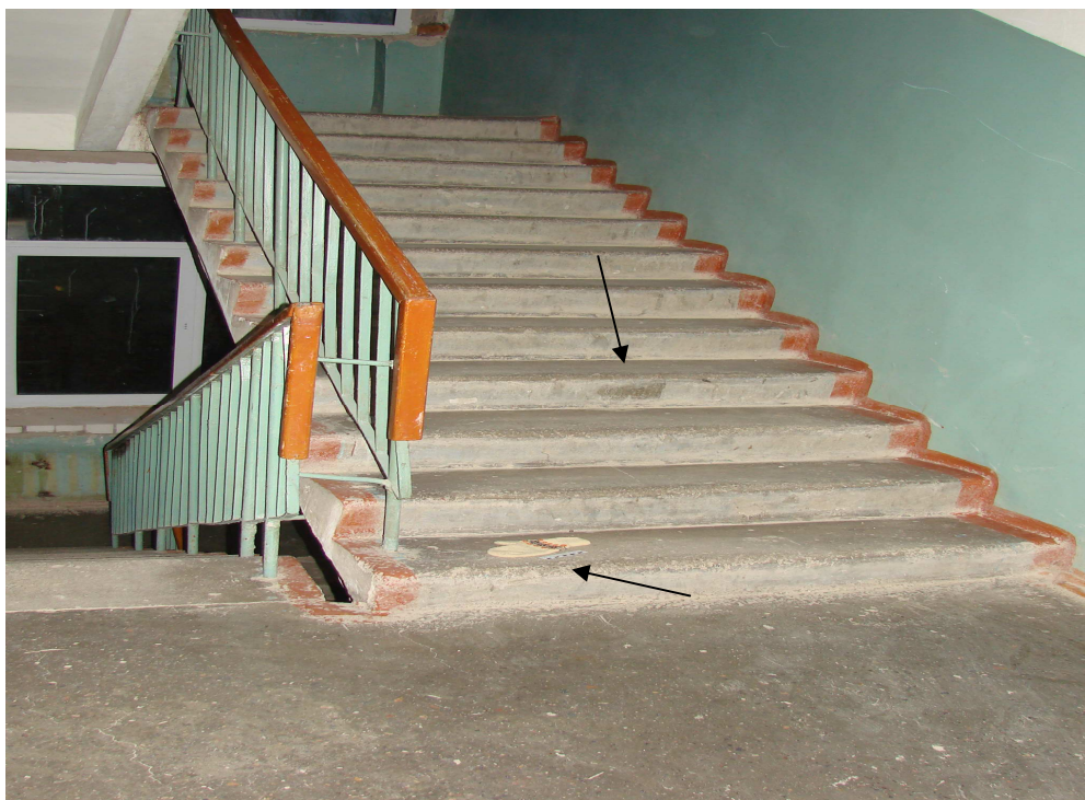
Фото N 3. Общій вид части лестницы на момент осмотра
