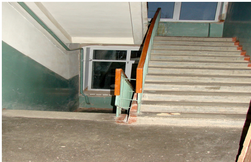
Фото N 2. Общий вид части лестничной площадки и лестницы на момент осмотра
