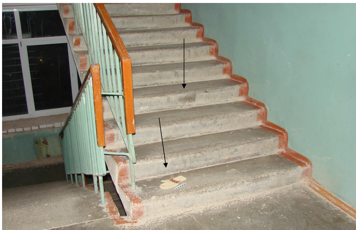
Фото N 4. Часть лестницы; вид на момент осмотра
