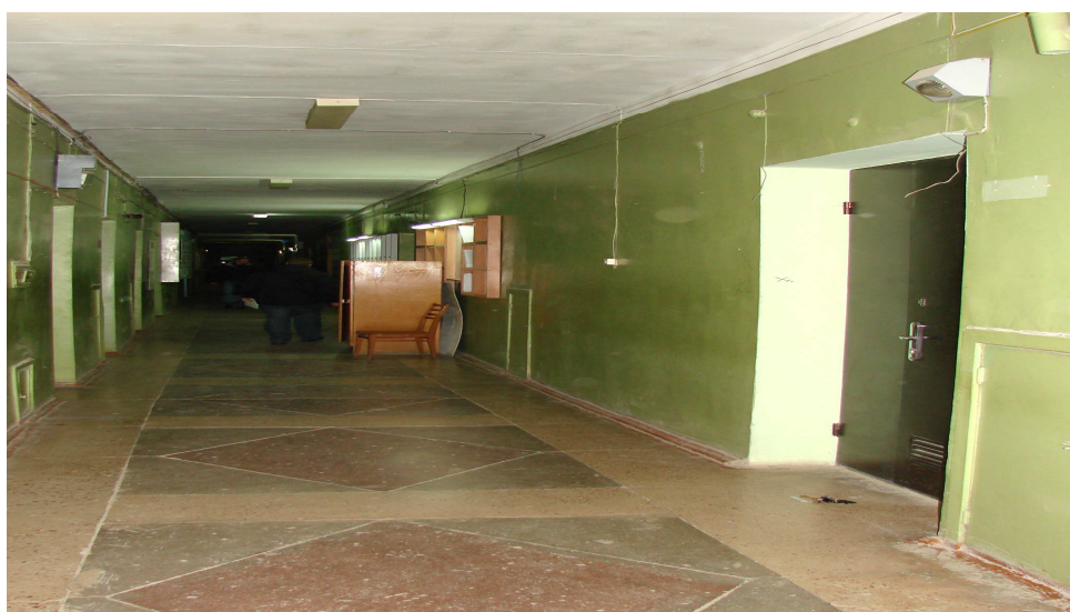
Фото N 2. Общий вид части помещения на момент осмотра со стороны окна
