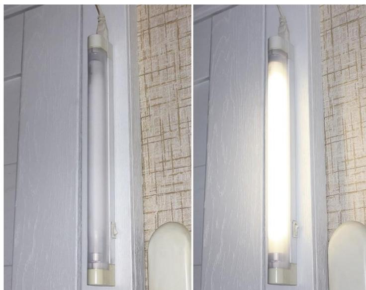
Газоразрядные лампы, в т. ч. люминесцентные, нельзя включать непосредственно в электросеть. Поэтому применяют специальные *пускорегулирующие аппараты (балласты)* – электромагнитный балласт и неоновый стартер, а также электронный балласт. В случае последнего заметного мигания ламп нет.
