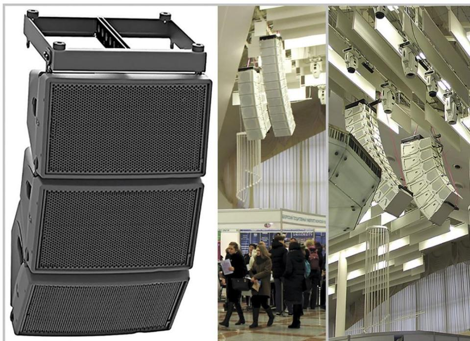
**Рисунок 3.26. – Звуковая колонка с вертикальным расположением громкоговорителей и пример размещения подобных колонок в интерьере здания Национального выставочного центра «БелЭкспо», г. Минск**
