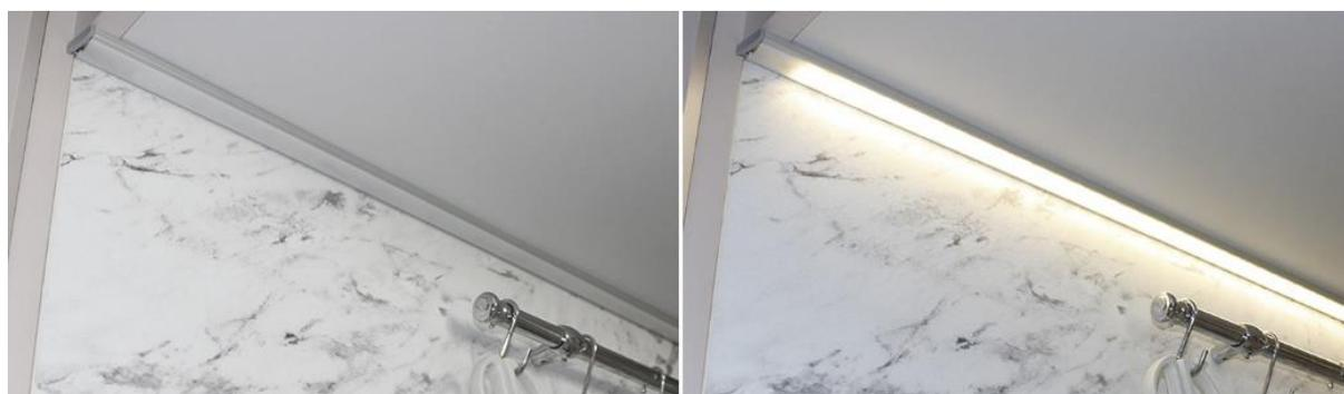
Рисунок 4.28. – Светодиодная лента в специальном корпусе, смонтированная на подвесном кухонном шкафе
