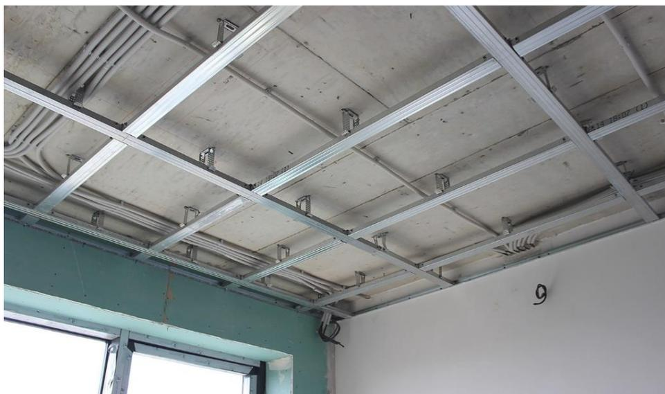
**Рисунок 1.25. – Подвесной потолок с еще не смонтированным ограждением из гипсокартонных плит**
