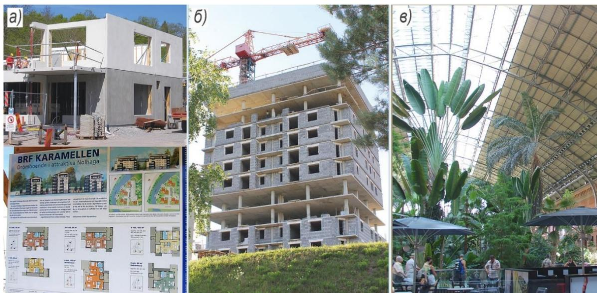
***a*** – формирование пространства с внутренними опорами в виде стен в случае крупнопанельного здания (г. Алингсос, Швеция); ***б*** – формирование пространства с внутренними опорами в виде колонн в случае сборно-монолитного железобетонного каркаса КУБ – каркаса унифицированного безригельного (г. Минск); ***в*** – пространство без внутренних опор (г. Мадрид, Испания)
