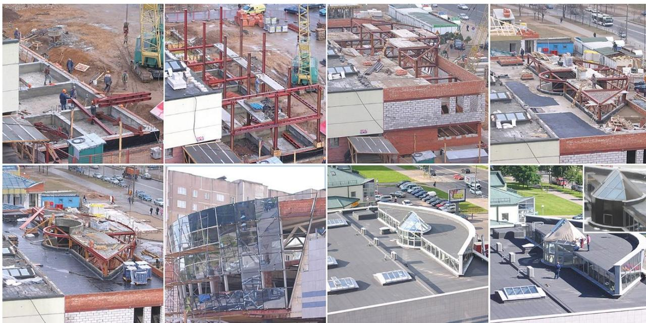
**Рисунок 1.3. – Этапы реконструкции универсама «Первомайский» в г. Минске; на последних двух снимках (справа внизу) показано устранение негативного влияния на световой климат части торгового зала излишнего остекления на крыше**
