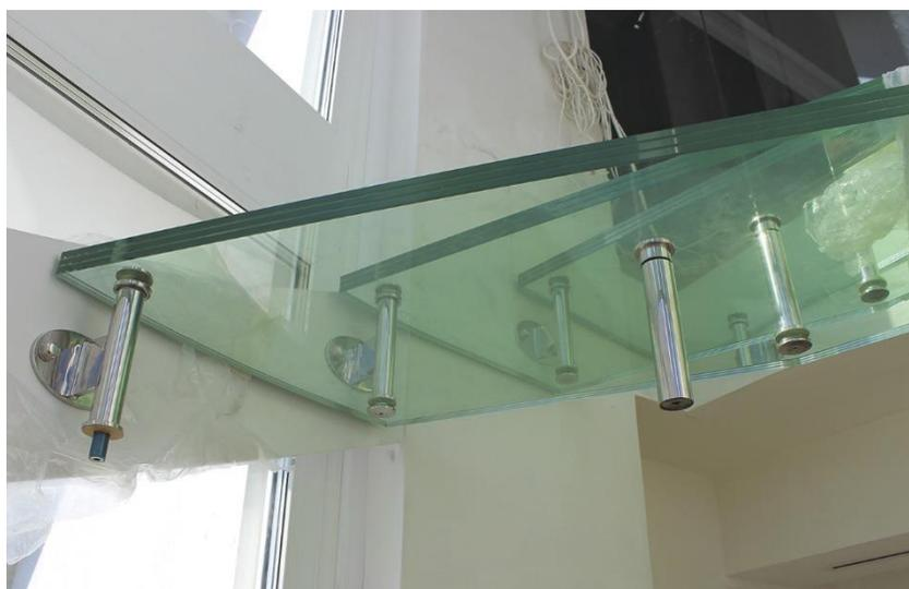
**Рисунок 4.23. – Стекланные ступени внутриквартирной лестницы, находящейся в процессе изготовления**
