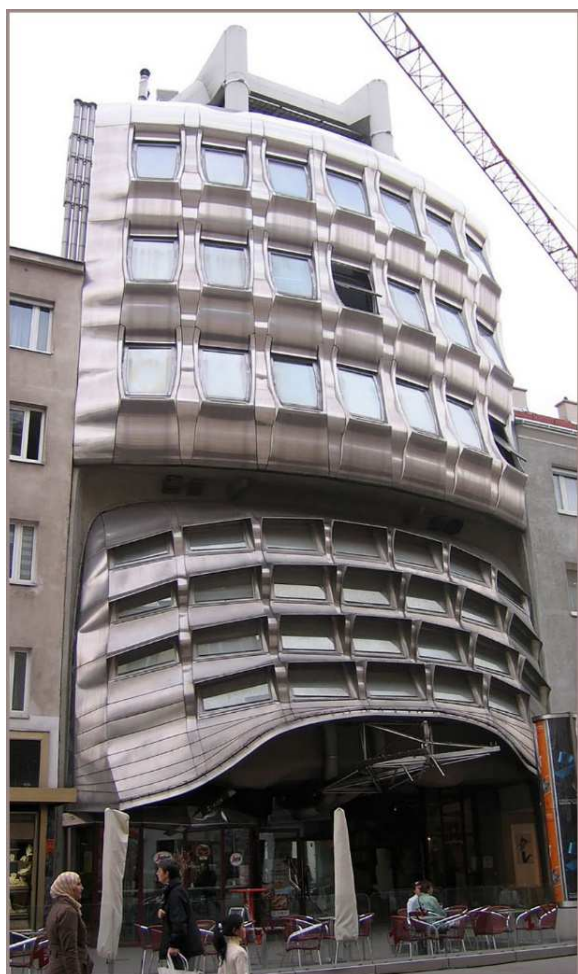
Рисунок 1.5. – Здание в г. Вене (Австрия) с облицовкой из листовой нержавеющей стали
