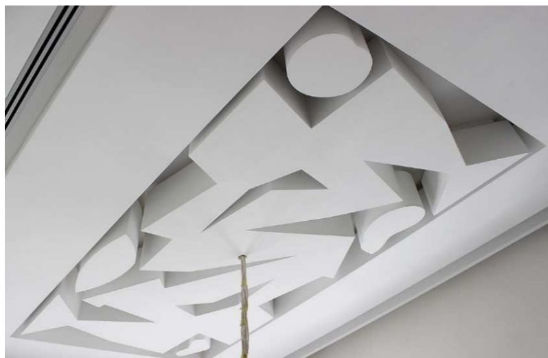
Рисунок 4.9. – Устройство декоративного потолка из пенополистирольных плит
