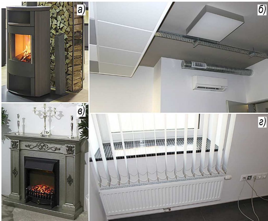
а – дровяной камин; б – электрический камин; в – островной подвесной потолок, осветительный прибор, металлический кабель-канал, воздуховод, настенный блок кондиционера воздуха; г – отопительный прибор, вертикальные жалюзи, встроенный блок розеток
