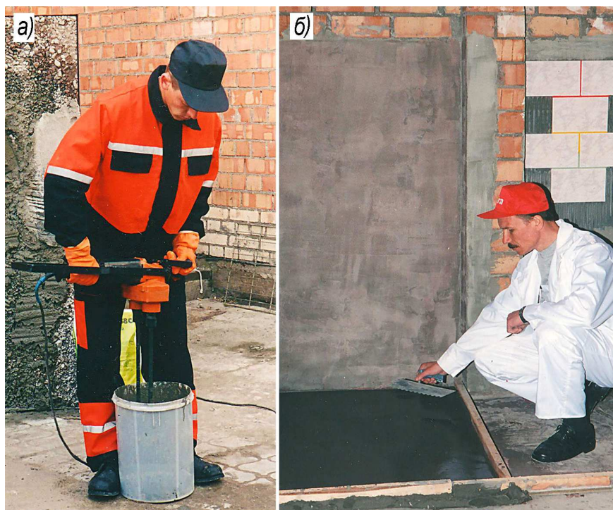
а – приготовление штукатурного раствора; б – устройство стяжки пола
