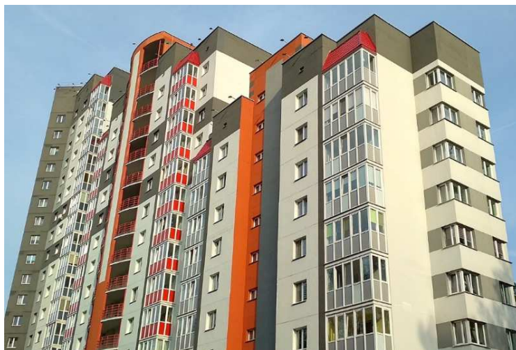
Рисунок 4.2. – Многоэтажный жилой дом с остекленными лоджиями в г. Минске
