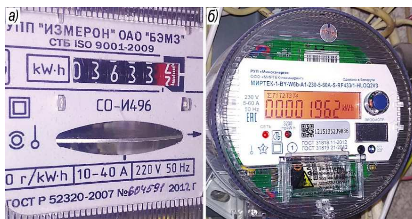
а – счетчик однофазный индукционный стационарный непосредственного включения; б – счетчик однофазный многофункциональный с электронной индикацией
