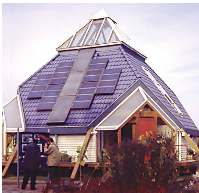
Рисунок 3.6. – Солнечные фотоэлектрические панели и коллекторы на экспериментальном вращающемся здании в г. Райне (Германия)
