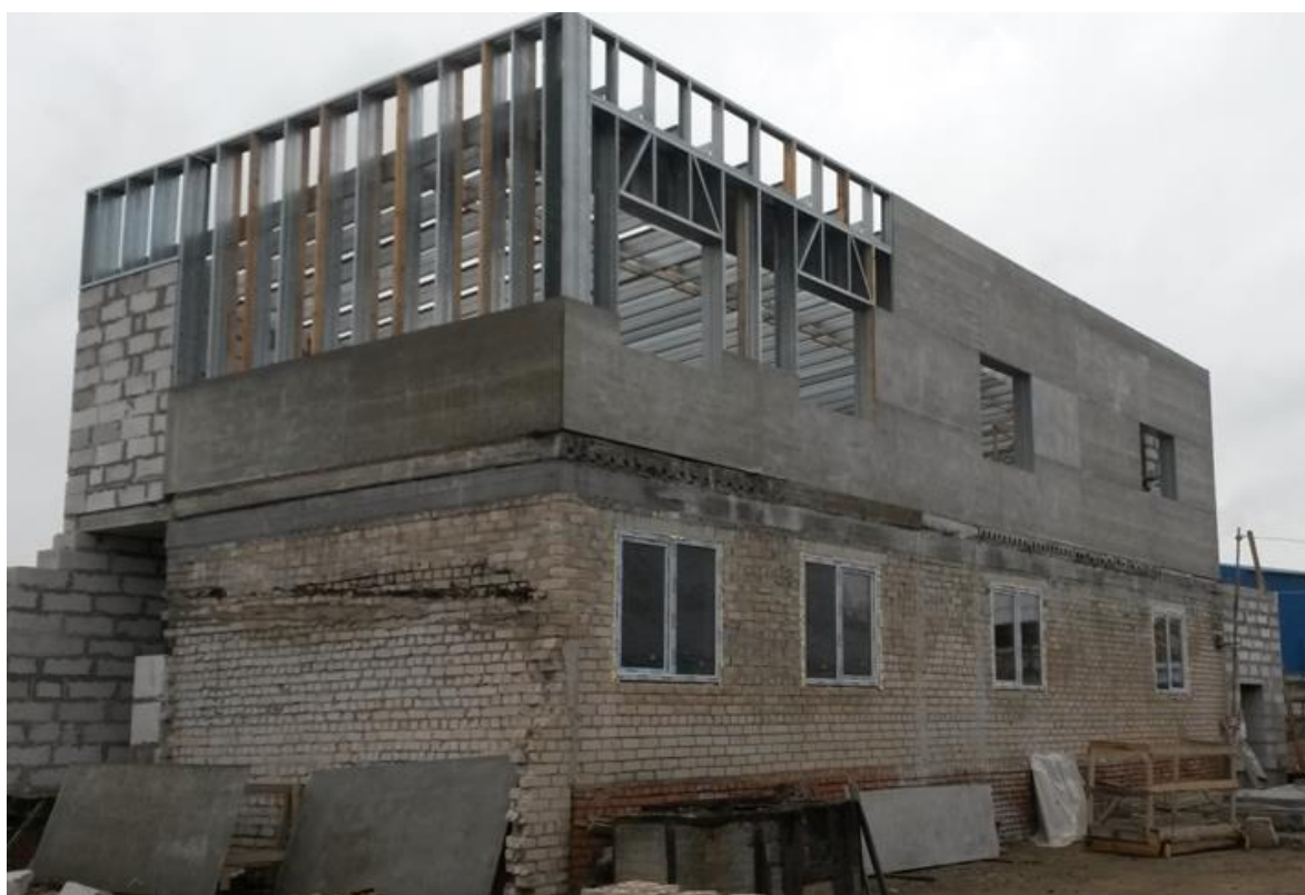
Рисунок 1. - Общий вид здания с каркасом второго этажа
