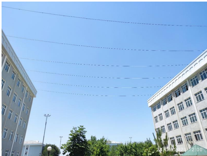
Рисунок 1. - Установка сплит-систем туманообразования на двух домах
