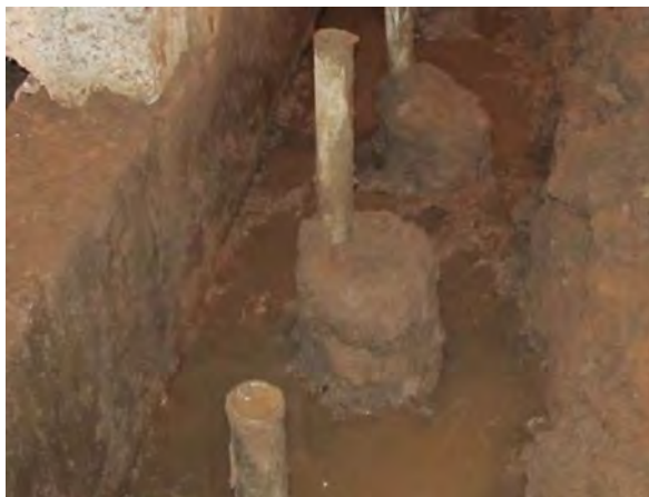
Рис. 4. Общий вид винтовых свай после откопки
