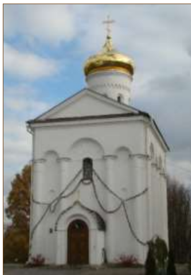
Рисунок 14. – Церковь Благовещения в Витебске и Спасо-Преображенский храм в Полоцке. Устройство новых глав с нитридтитановым покрытием «под золото».
