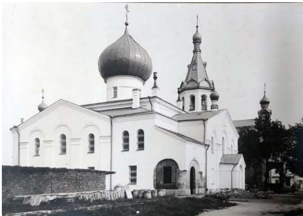
Рисунок 2. – Никольская церковь в процессе реставрации 1910–1913 гг. Вид с северо-запада на Тихвинский придел и паперть. Фото Н. И. Репникова. 1912 г. [7]
