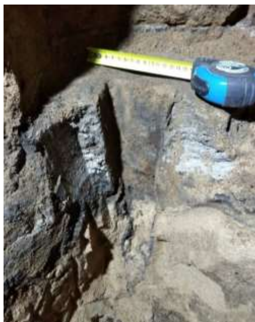
Рисунок 2. – Полость-«стакан» от сгнившей четырехгранной сваи
