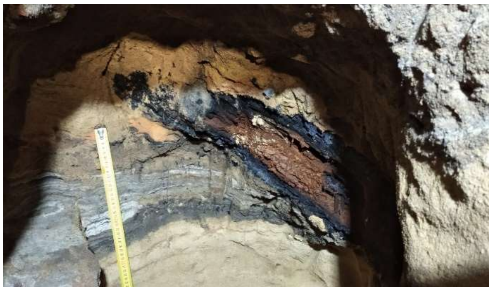
Рисунок 3. – Техногенные накопления под подошвой фундамента юго-восточного пилона Рождественского собора
