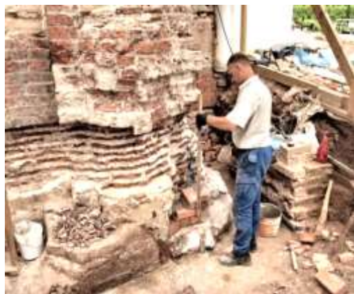
Рисунок 14. – Удаление дефектной кладки фундамента юго-восточного угла церкви
