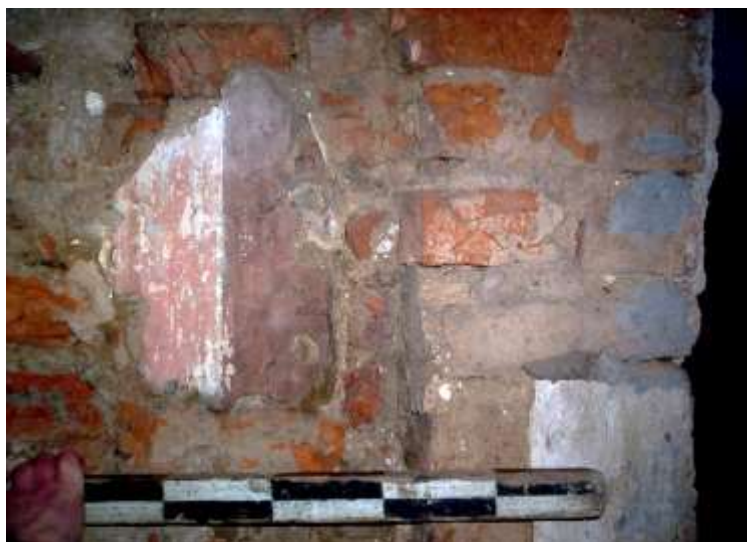
Рисунок 2. – Полоцкий иезуитский коллегиум, корпус «Б» (бывшая главная библиотека): паз для оконного блока XVIII в. между фреской и кирпичной четвертью
