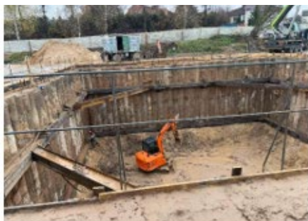
Общий вид ограждающих конструкций котлована
