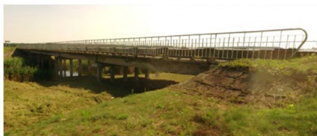
Общий вид транспортного сооружения
