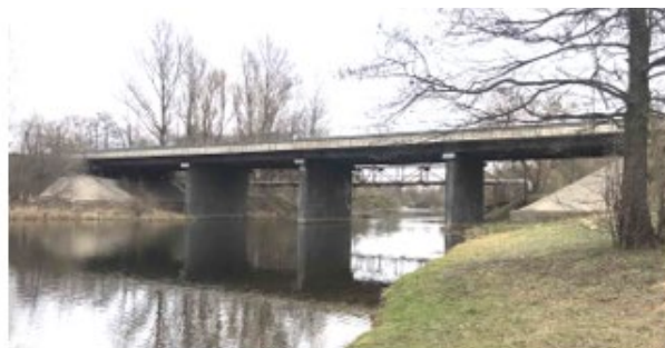
Общий вид транспортного сооружения
