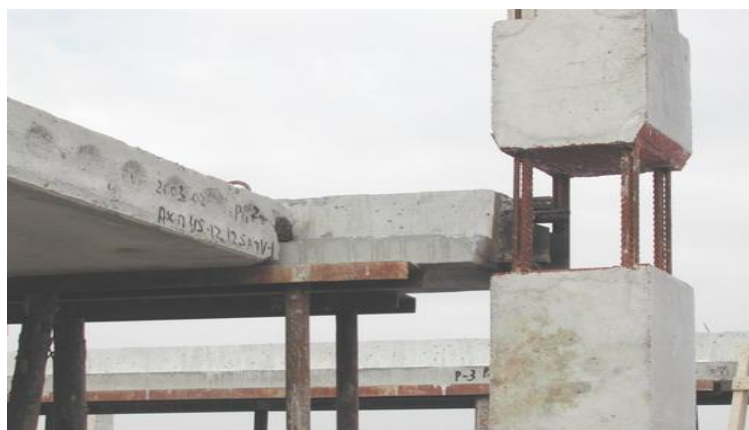
Рис. 2. Опирание многопустотных плит с подрезкой на ригели
