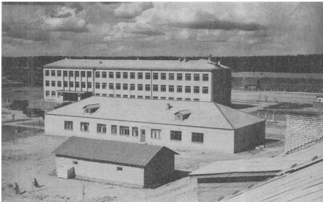
Будынак новапабудаванай школы.
