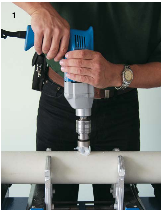
1 Специальной фрезой высверлить отверстие для седла
